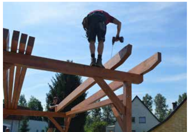
5. Schritt: Sparren anbringen
