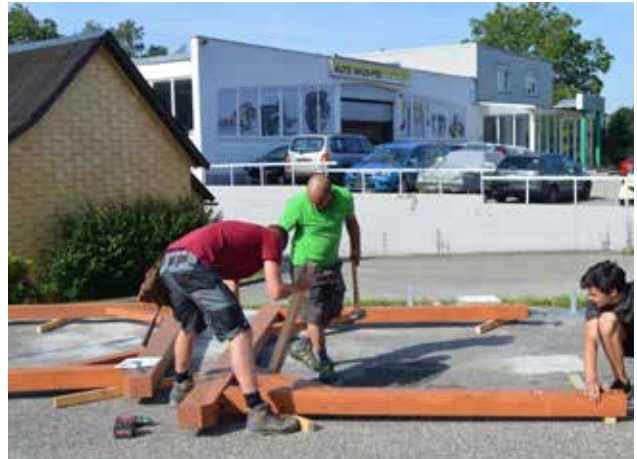
2. Schritt: Wände zusammensetzen
