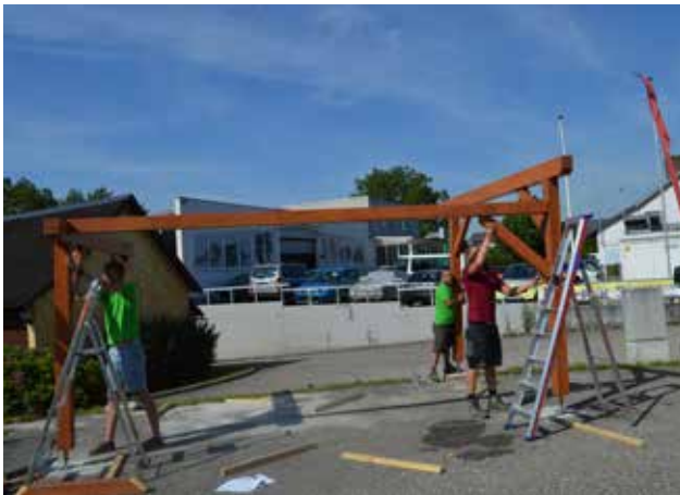
4. Schritt: Wände verbinden
