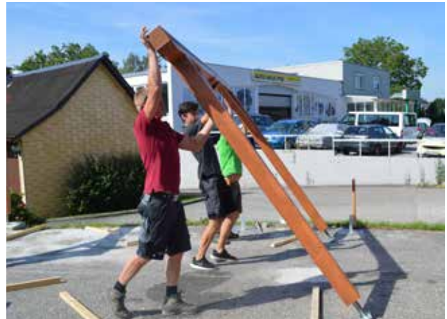
3. Schritt: Wände aufstellen
