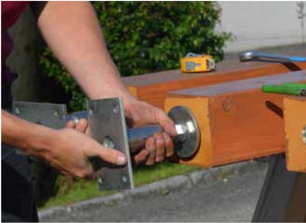
1. Schritt: Stützfüße montieren
